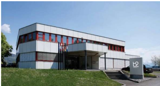
Abbildung 1 - Hauptgebäude in Klaus
